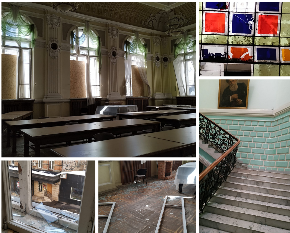
Ушкодження приміщення ХДНБ ім. В. Г. Короленка. Фото ХДНБ ім. В. Г. Короленка
